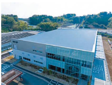
▲ K I C棟（新棟）全景
