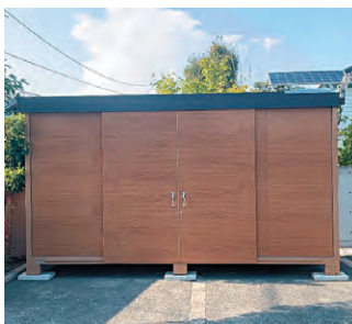
▲ アイビーエメラルドホール前防災倉庫
