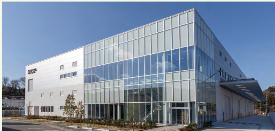
熊本イノベーションセンター新棟
